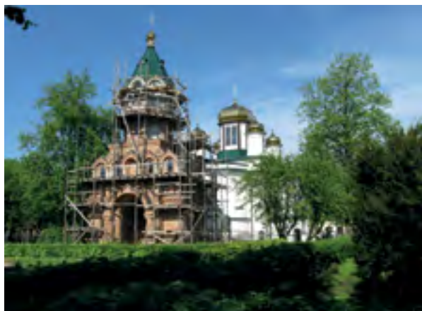
Dzwonnica w trakcie rozbudowy
