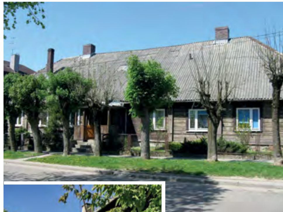
Drewniany dom na ul. Ściegiennego
