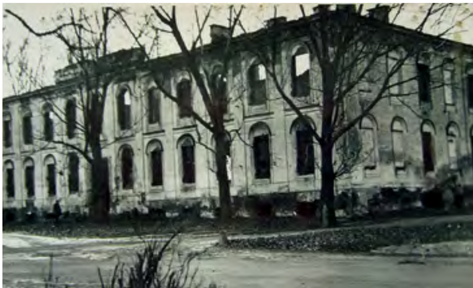
Spalony budynek koszar
